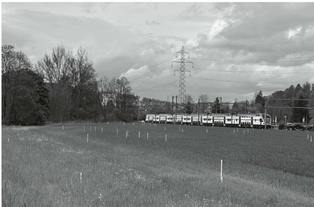
Weisse Pflöcke ragen aus dem Getreidefeld bei der Einmündung der Kempt in die Töss. Sie markieren die Umrisse der Bauten für den Brüttentunnel. Aktuell sind die Pläne ausgestellt. (Bild: me)
