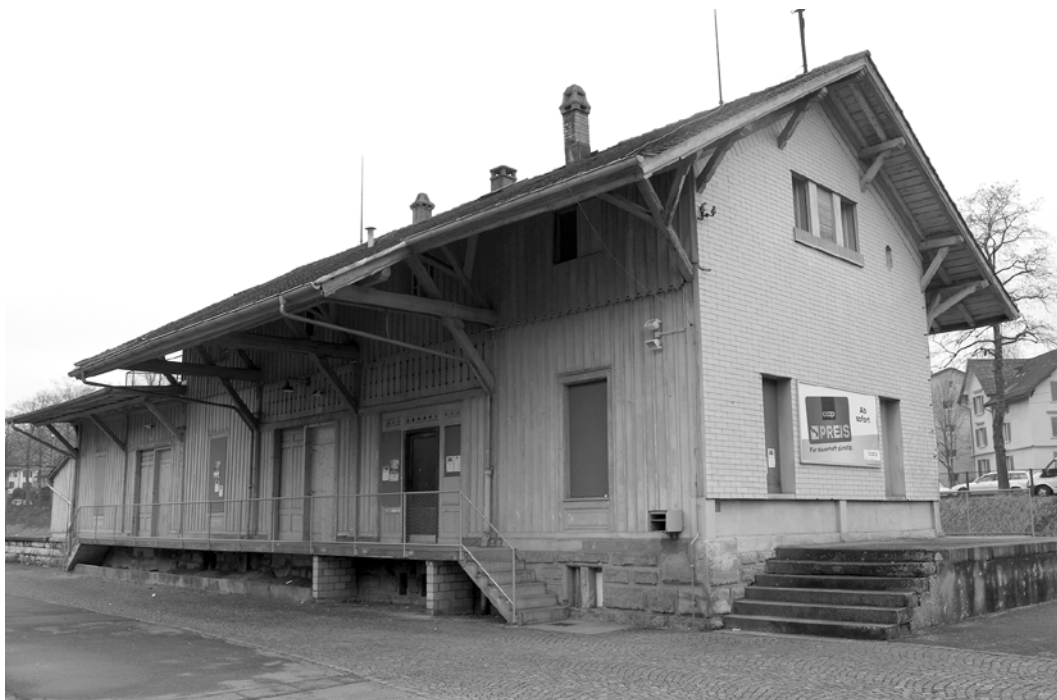
Für den Güterschuppen wurden im Budget erhebliche Mittel eingestellt. Stimmt das Parlament dem Vorschlag zu, soll er nächstes Jahr saniert werden. (Bild: me)
