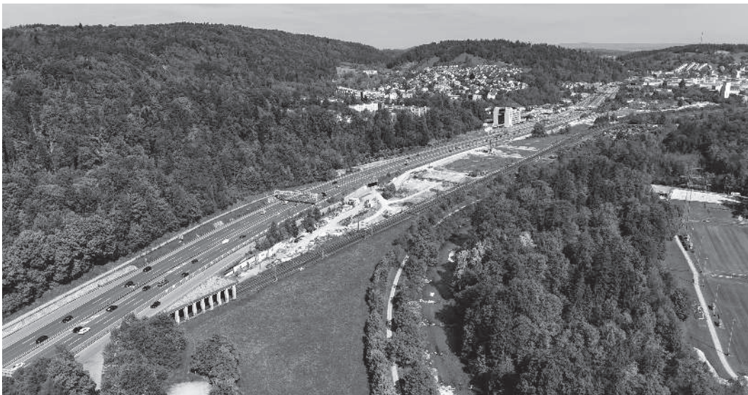
Vorbereitungen auf die Arbeiten am neuen Tunnelportal zwischen Autobahn und Bahnlinie. (Foto: Nadia Pettannice)
