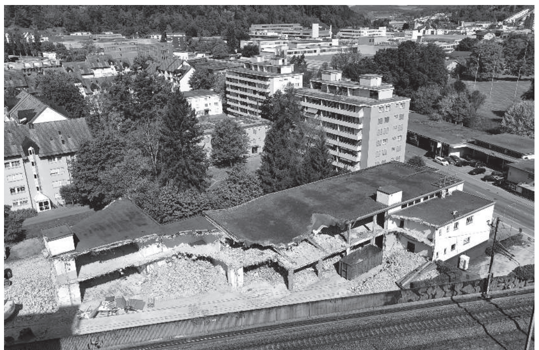
Das Gewerbegebäude an der Auwiesenstrasse 1 wird abgerissen. (Foto: Nadia Pettannice)
