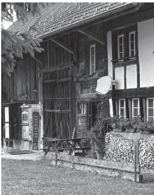
Südseite des Kernhauses (3/2) mit dem alten Scheunentor.
