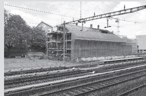
Der verhüllte Güterschuppen wird saniert. (Bild me)
